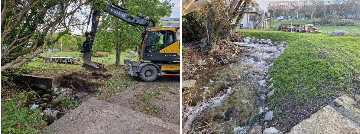
September 2024 och arbetet med riva bort muren vid kopparsviksbäcken genomförs (t v). Efter avslutat arbete har muren ersatts av en naturligare och för fisken mer lättpasserad strömsträcka (t h). Foton: Joakim Lyander
